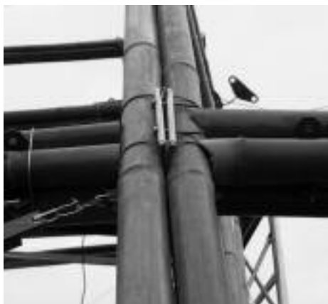
Figura 11. La piastra di aggancio della struttura alla platea. Olivetta San Michele (IM), ottobre 2008.
