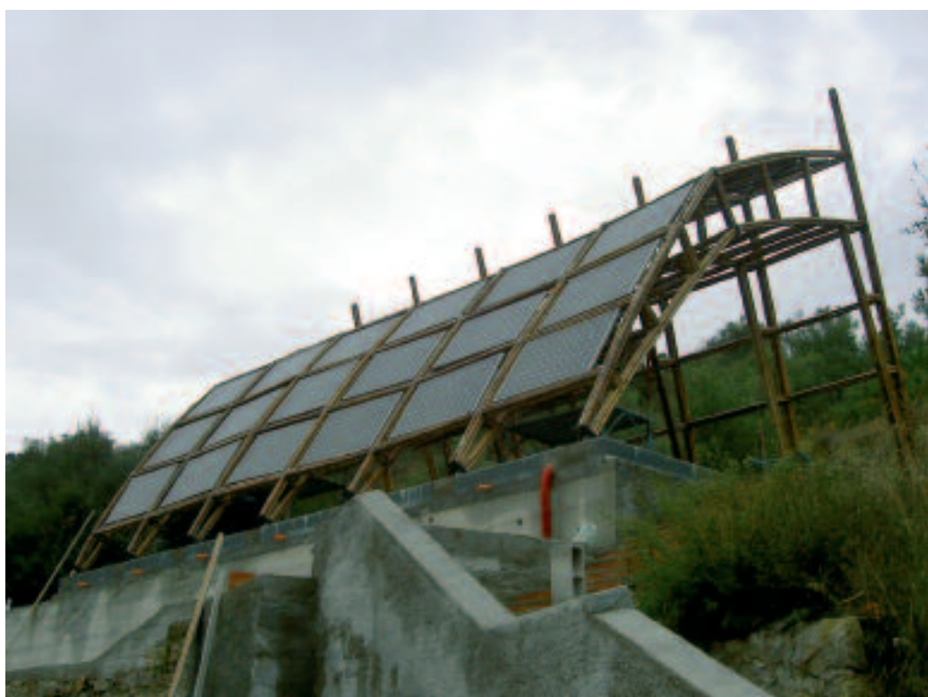
Figura 1. Vista generale del padiglione con struttura in bambù-acciaio e vela fotovoltaica a Olivetta San Michele (IM), ottobre 2008.
